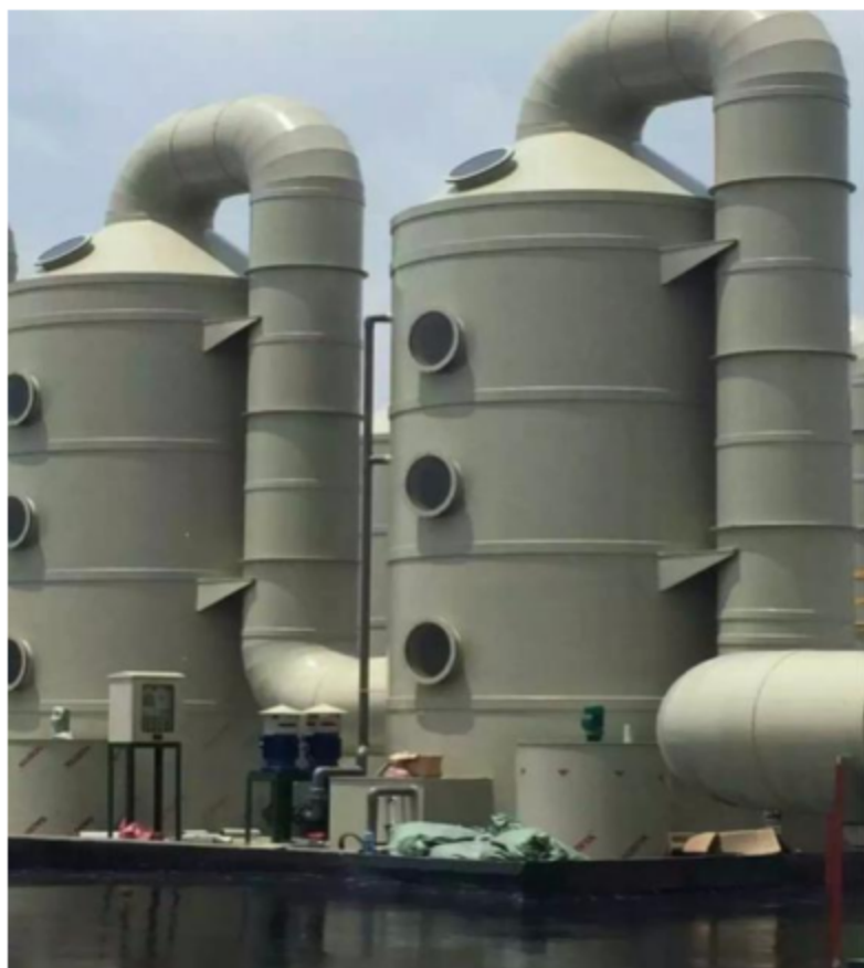
图 6.3-2 生物除臭塔装置图
